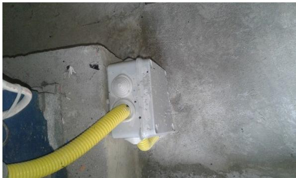
Caixa de passagem resistente a água a mesma utilizada em piscina.
