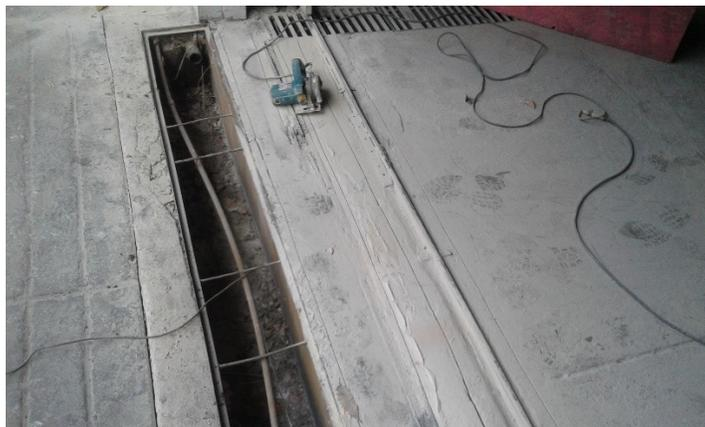
Corte do piso para retirada da grelha antiga e troca do trilho.
