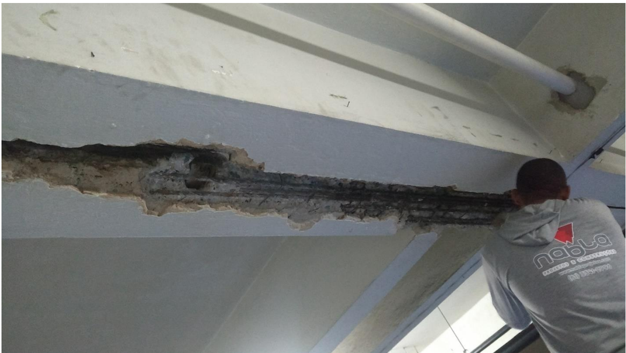
RECUPERAÇÃO ESTRUTURAL DA VIGA DA GARAGEM
