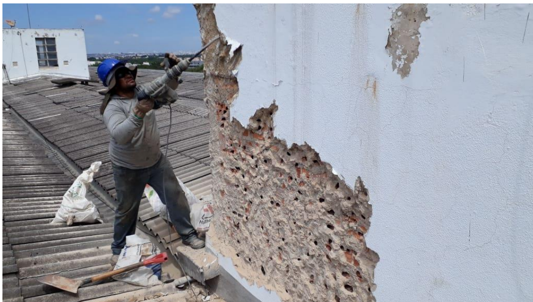
RETIRADA / DEMOLIÇÃO DO REVESTIMENTO DA CASA DE MÁQUINAS / RESERVATÓRIOS
