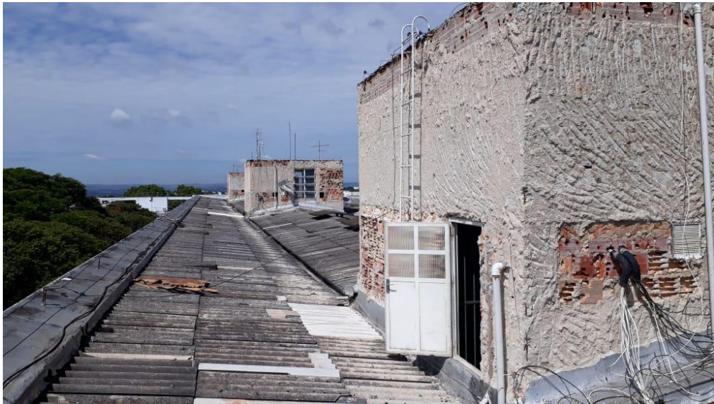
PAREDES EXTERNAS COM CHAPISCO
